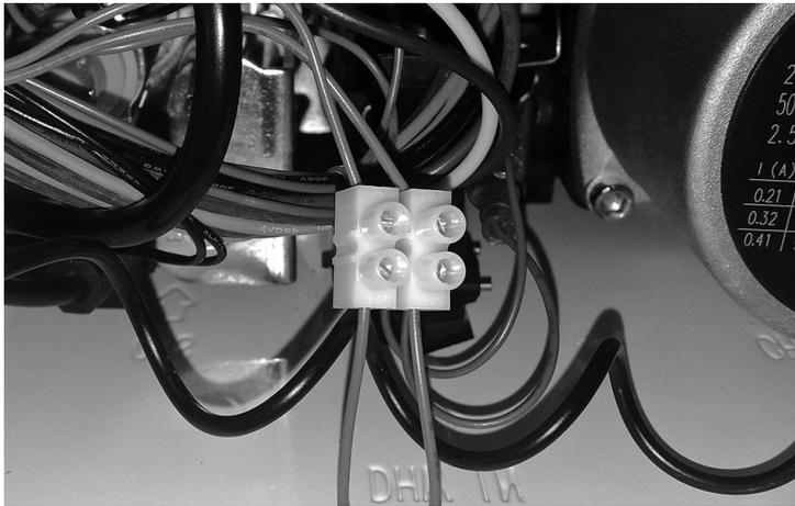
Рис. 7. Доступ к клеммной колодке подключения комнатного термостата
