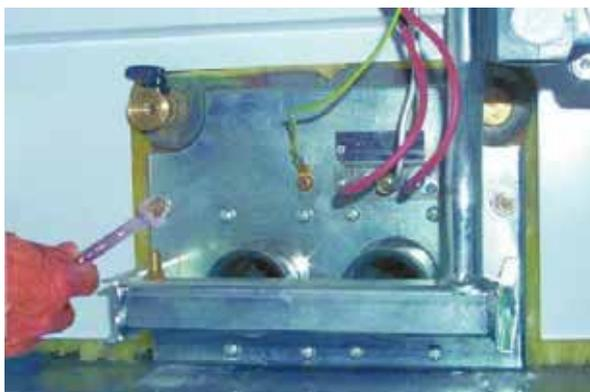
рис. 22 - Демонтаж горелок
